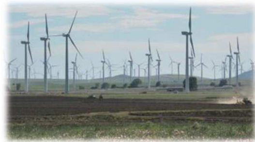
« Mur » d'éoliennes dans la région de Tarifa, Espagne (R. D'Agostino, Écosphère)
